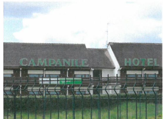
Enseigne installée sur toiture à 2 pans
