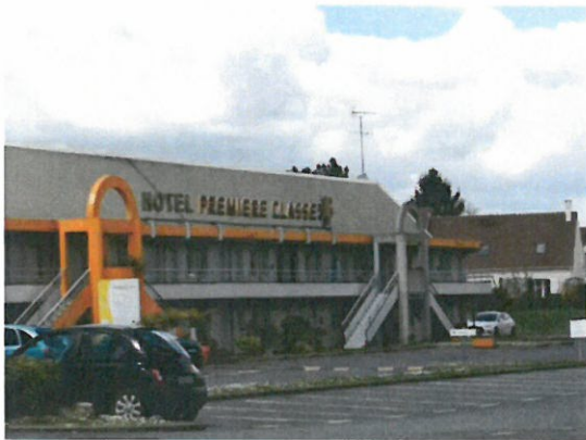
Enseigne installée en toiture à deux pans
