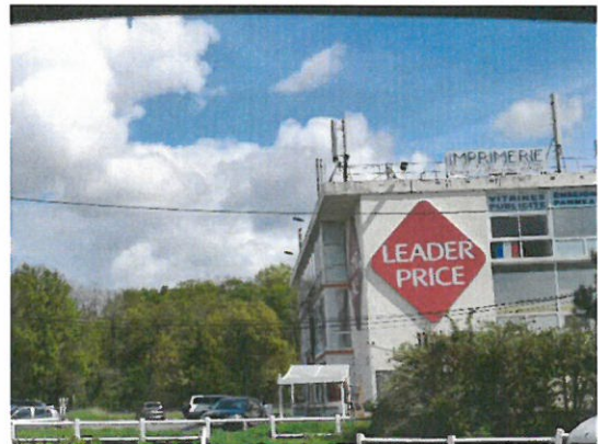
Enseigne installée en toiture terrasse
