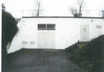
Réservoir de Survilliers
