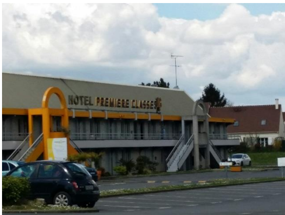
Enseigne installée en toiture à deux pans
