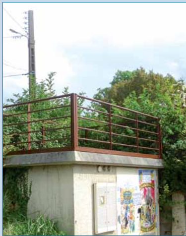
Remise en sécurité du transformateur EDF de la rue des Coteaux.
