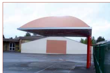
Mise en place d'un préau dans la cour Maternelle.
