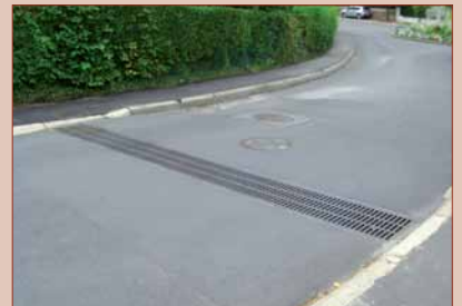
Remplacement des grilles EP rue des Coteaux et rue Chauffour.
