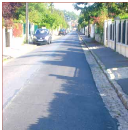
Réfection sur toute la longueur de la rue de Bertinval sur une demi-largeur de route.
