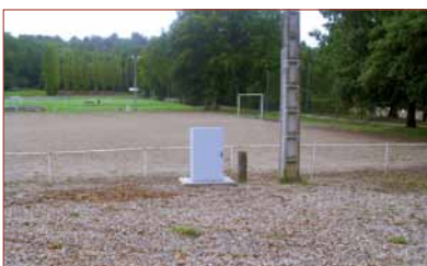
Remplacement et remise en conformité des armoires d'alimentation de l'éclairage du terrain d'entraînement.
