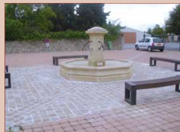
Mise en place d'une fontaine au centre de la place de l'école.
