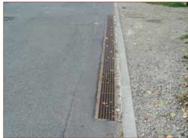
Réfection voirie devant 16 rue de la Genestraye (suite aux des travaux réseaux d'eau pluviales), et réfection du fil d'eau pluvial afin d'éviter des inondations.
