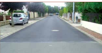
Réfection voirie rue Henri Dunant
