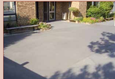
Cour maternelle (reprise de la surface afin d'évacuer les eaux de pluie stagnantes)
