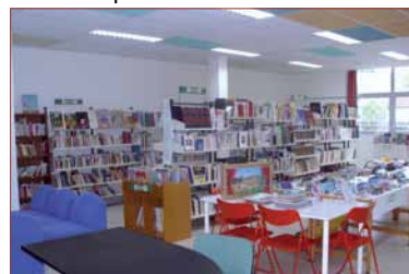
La réfection a porté sur l'agrandissement de cette salle, le remplacement de l'éclairage, la rénovation des murs et la mise en place de carrelage au sol.
