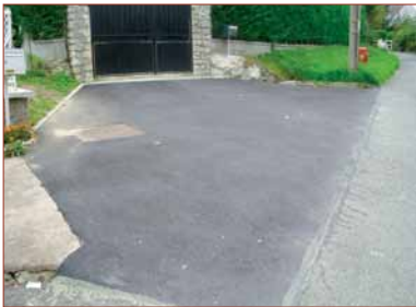
Réfection voirie devant 16 rue de la Genestraye (suite aux des travaux réseaux d'eau pluviales), et réfection du fil d'eau pluvial afin d'éviter des inondations.
