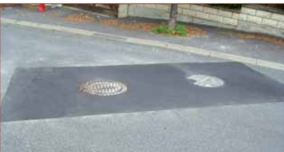
Réfection affaissement et tampons rue des Coteaux.
