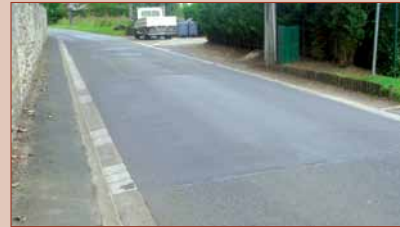
Rue A. Vassord = > reprise voirie entrée de ville.
