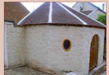
Réfection totale de l'ossuaire par les ateliers municipaux.
