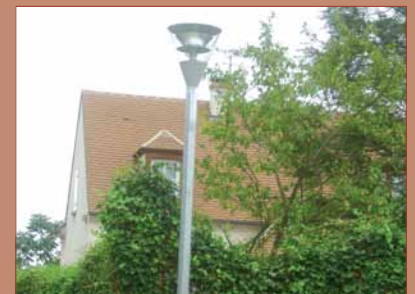
Création d'un éclairage Impasse des Commissions (entreprise STPEE)
