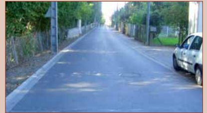
Rue la Guillotte = > reprise voirie entre les deux ralentisseurs.
