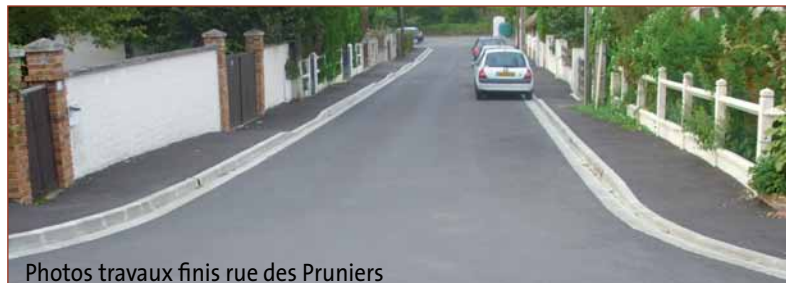
Photos travaux finis rue des Pruniers
