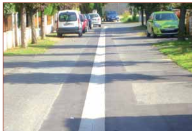
Réfection voirie Croix des alouettes
