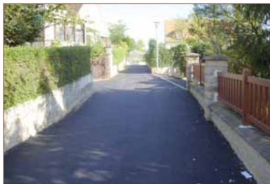
Réfection de la voirie impasse des commissions.
